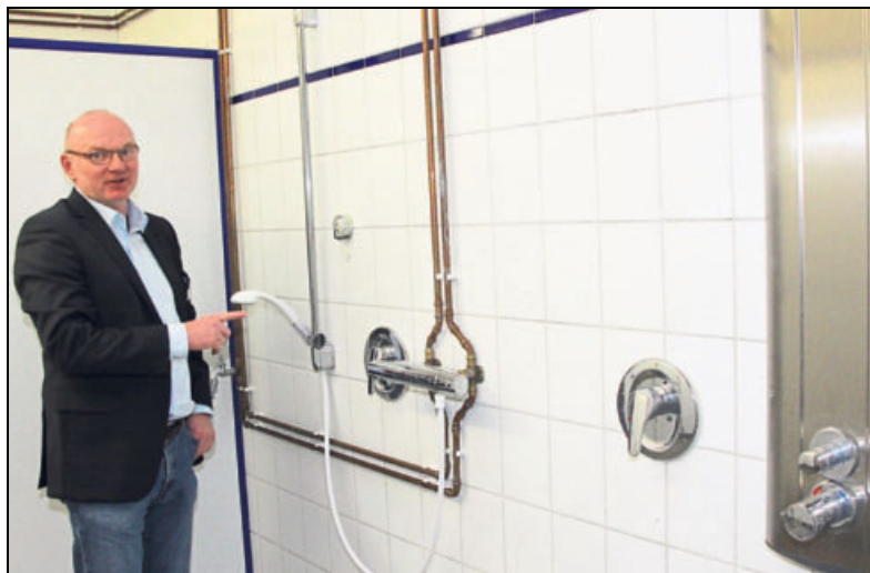
Schulleiter Axel Grothe zeigt die neuen Duschköpfe und Aufputzleitungen im Sanitärbereich der Schwimmhalle. Foto: Koteräs-Pietsch
